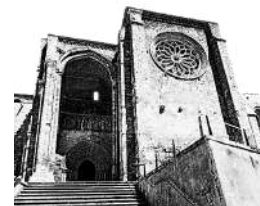
Iglesia Sta Mª La Blanca
